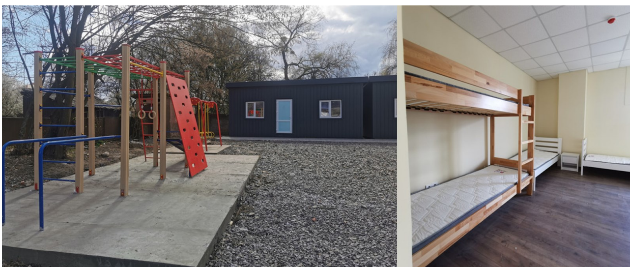
Модульні будиночки з спортивним майданчиком для дітей та відремонтовані кімнати гуртожитку для ВПО
